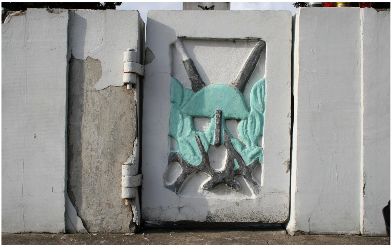
NOWOGRÓD, POMNIK MŁODYM BOHATEROM 1920. , FURTA OGRODZENIA – STAN OBECNY. WIDOCZNE PRZEKSZTAŁCENIA FORMALNE ORAZ LICZNE WARSTWY PRZEMALOWAŃ NA POWIERZCHNI
