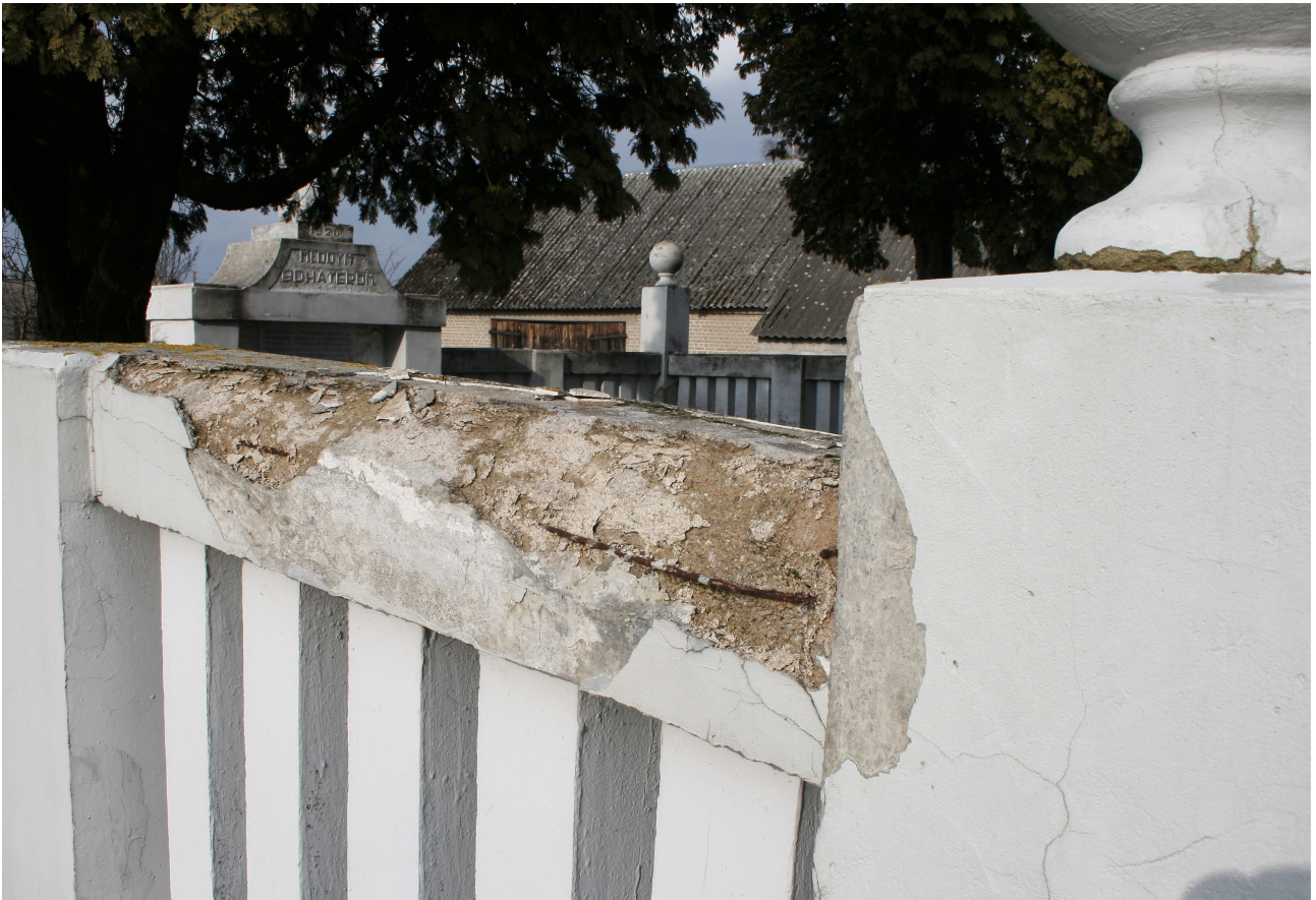
NOWOGRÓD, POMNIK MŁODYM BOHATEROM 1920. ZAPADNIĘCIE POŁUDNIOWEGO NAROŻNIKA OGRODZENIA SPOWODOWAŁO PĘKANIE I DESTRUKCJĘ ELEMENTÓW BETONOWYCH WRAZ Z KOROZJĄ ZBROJENIA
