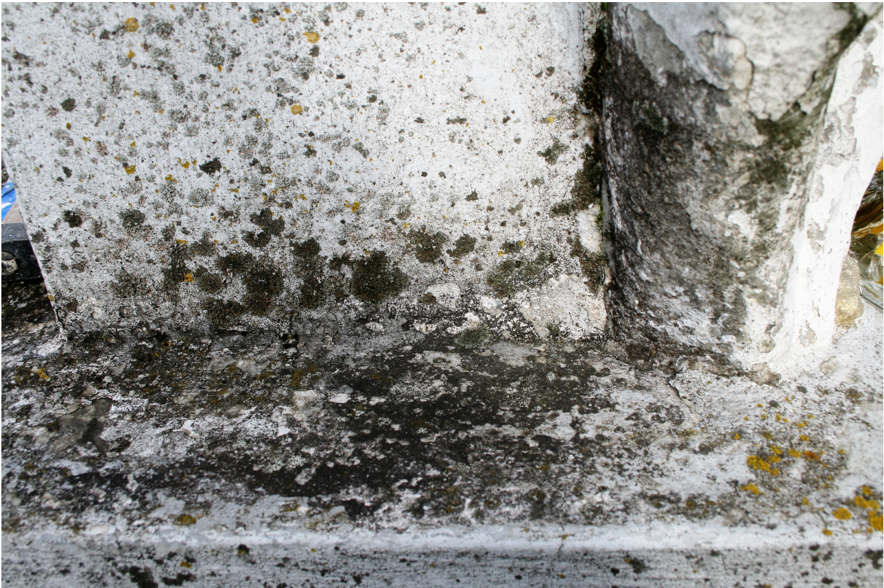
NOWOGRÓD, POMNIK MŁODYM BOHATEROM 1920. PORASTANIE MIKROORGANIZMÓW NA ZAWILGOCONYCH POWIERZCHNIACH
