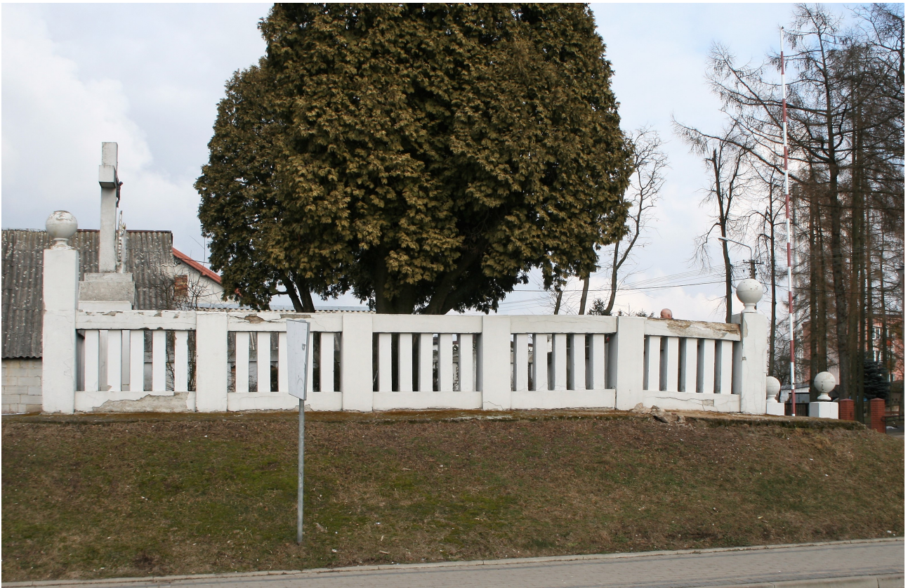
NOWOGRÓD, POMNIK MŁODYM BOHATEROM 1920. ZAPADNIĘCIE POŁUDNIOWEGO NAROŻNIKA OGRODZENIA SPOWODOWAŁO PĘKANIE I DESTRUKCJĘ ELEMENTÓW BETONOWYCH WRAZ Z KOROZJĄ ZBROJENIA
